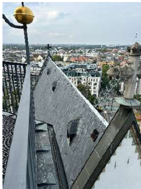
Blick über das gewaltige Dach
