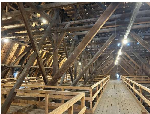
Blick in den Dachboden
